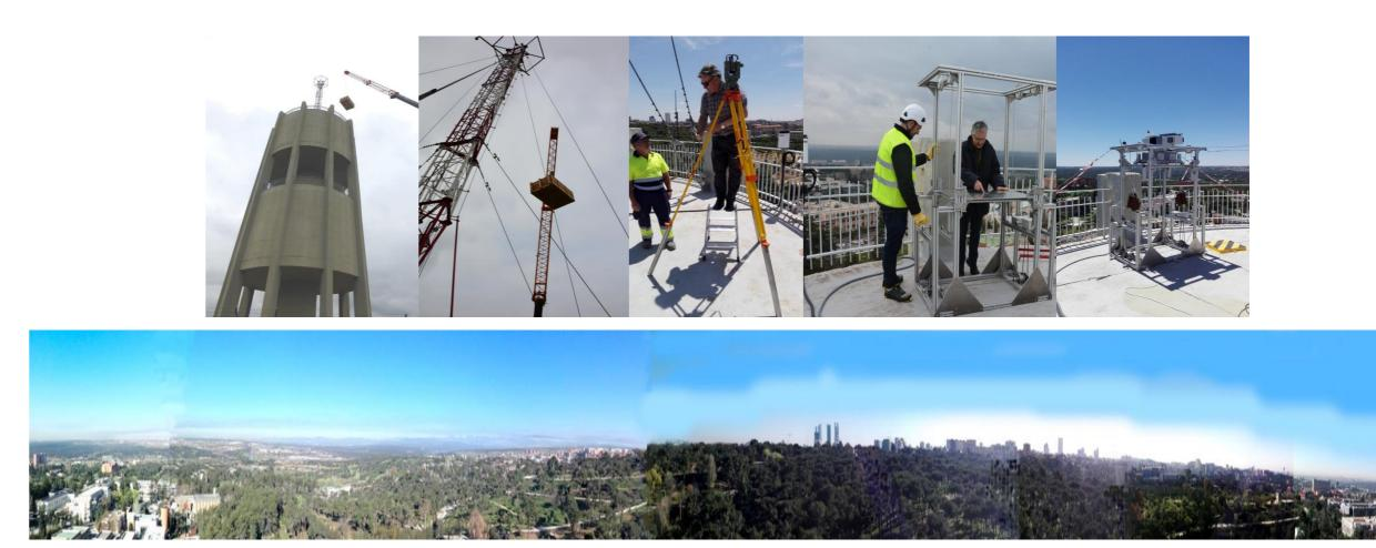
En Junio de 2020, se realizó el montaje del instrumento MAX-DOAS-2D en la estación de medida del CIEMAT. Se ha realizado la puesta en marcha del instrumento y su calibración en cuanto a ángulos vertical y acimutal. Para una primera comprobación del correcto funcionamiento del instrumento, se procedió a la obtención de las columnas verticales de NO2 y de los correspondientes mapas bidimensionales, usando los espectros obtenidos durante un día en condiciones de baja nubosidad.
